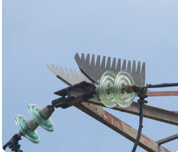
Този гребен предотвратява кацането на птици в опасна част от електрическия стълб.
