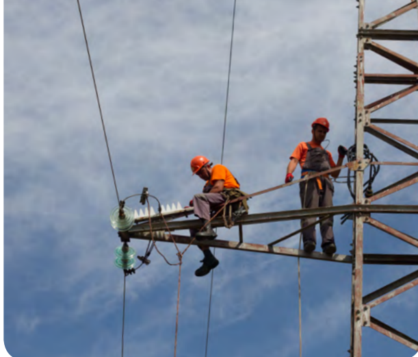
Монтиране на предпазители за птици на електрически стълбове
